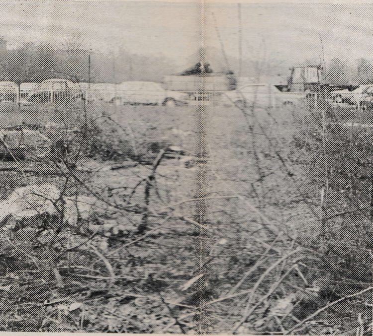
die dem Zugang des Fußgängertunnels unter der Neusser Straße weichen das Erdreich vor dem Tunnel weggeräumt werden. Bild: Breustedt
